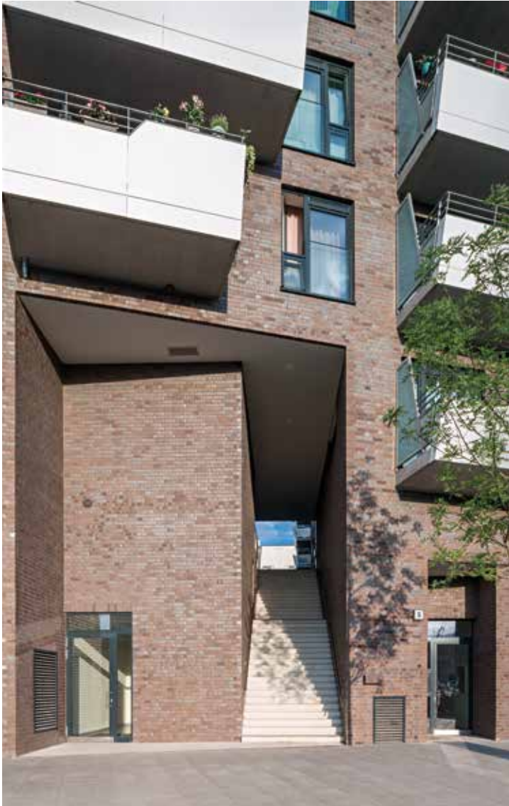
Eine eingeschnittene Treppe führt von der Straße auf das 6 m hohe Hofniveau.
