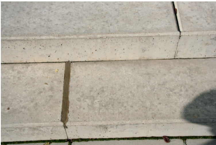
Bild 2: Ausspachtelung der Rillen (Quelle: Jutta Curtius)
