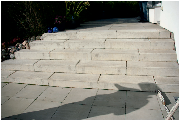
Bild 1: Treppenstufenanlage aus Sichtbetonfertigteilen (Quelle: Jutta Curtius)
