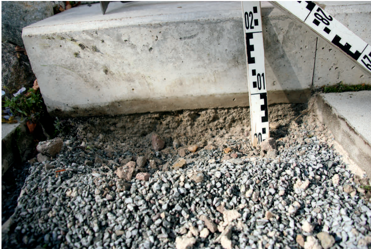
Bild 3: Vorhandene Tragschicht der Blockstufen von 8 cm (Quelle: Jutta Curtius)
