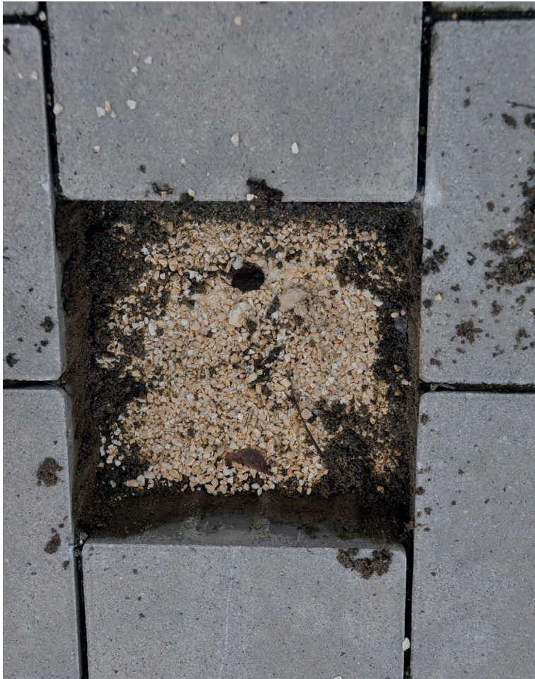
Bild 5: Der dunkle Fugensand und der helle Kalksplitt als Bettungsmaterial 2/5 (Quelle: Christine Andres)
