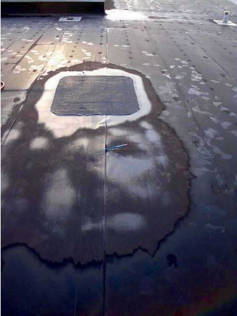
**Bild 2:** Etwa sechs Jahre alte Dachabdichtung mit einlagiger (Bitumen) Bahn – Naht unzureichend geschlossen (Quelle: Jürgen Lech, BFD Essen)
