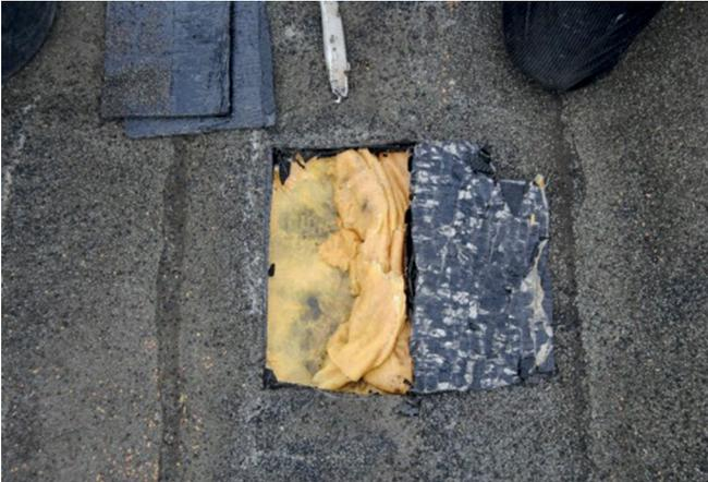
**Bild 3:** Unbemerkt zerfallene, aufgelöste Mineralfaserdämmung
