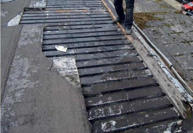
**Bild 1:** Im vorderen Bereich ist die Traufbohle ergraut, verfault, die Oberfläche des Trapezbleches dunkler, zum Teil verrostet. – Primäre Ursache: nicht erfolgte Instandsetzung (Quelle: Jürgen Lech, BFD Essen)
