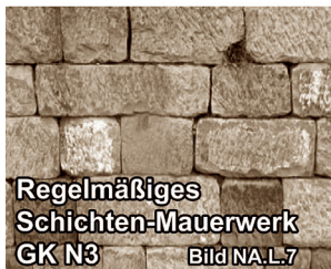
Bild 1: Zusammenstellung der Mauerwerksverbände (Quelle: Diebel nach DIN EN 1996-1-1/NA)
