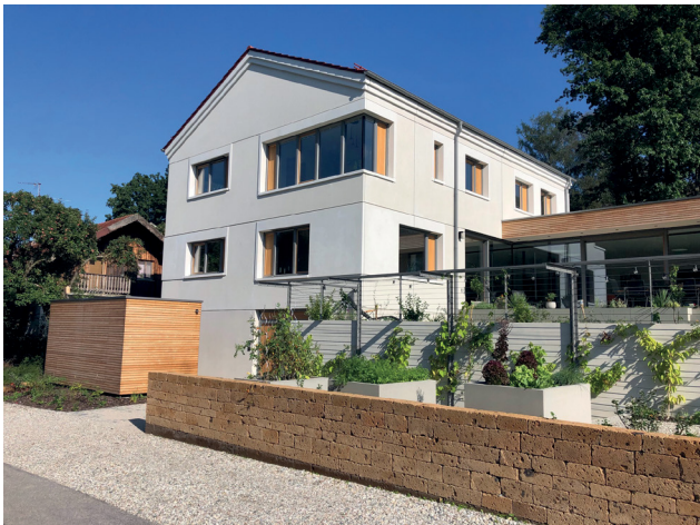
Bild 1: Wohnhaus mit Fassade aus Sandwichelementen (Quelle: Laumer Bautechnik GmbH)
