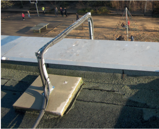
Abb. 4.5-9: Trennungsabstand eingehalten, Quelle: VGH Versicherungen
