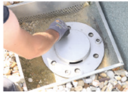
Bild 8: Retentionsablauf für Flachdächer (Quelle: LOROWERK)
