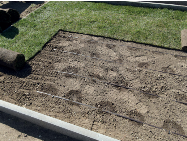
Bild 3: Unterirdische Verlegung von Tropfrohren unter Rollrasen (Quelle: Thon, Stein, Kohl, Friedmann; 2021)
