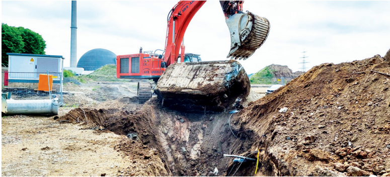
Abb. 3.2.2.1-1: Beispiel für einen Ortbeton-/Fertigteilschacht aus der Baureifmachung des ehem. KKW Mülheim-Kärlich, ca. 5 x 3 x 2,5 m (Quelle: Kamrath)
