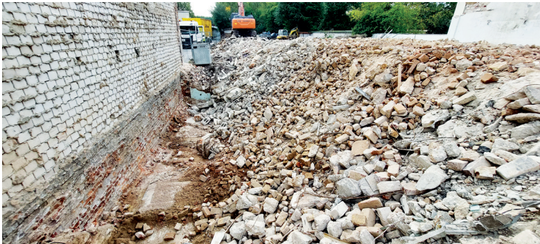
Abb. 3.2.2.2-1: Mischschutt von einem Gebäude aus Ziegel-, Betonstein- und Bimsbetonmauerwerk; der Schutt sollte nochmals mit einem Magneten vom Schrott befreit werden. Danach könnte das Material als Typ-2- oder Typ-3-Splitt verwertet werden. (Quelle: Kamrath)
