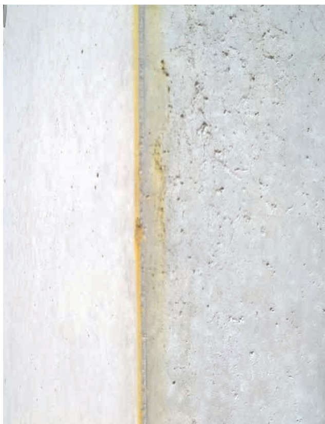
9 | Sichtbetonoberflächen mit deutlich unterschiedlicher Porrigkeit der Wände an der Kante. Im oberen Bereich von Wänden lässt sich dies meist durch Nachverdichten reduzieren, aber nicht gänzlich vermeiden, Verfärbungen können durch zu viel Trennmittel verursacht werden.
