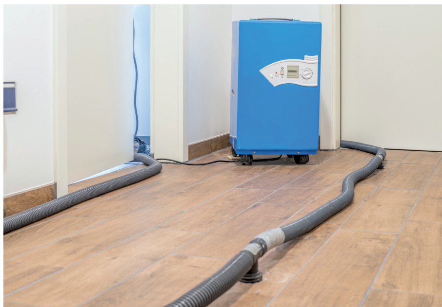
Bei einem Wasserschaden müssen die vollgelaufenen Räume zunächst leergepumpt werden.
