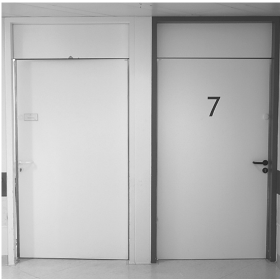
Abb. 2.12-4: Positiv: Die Tür zum Patientenzimmer hebt sich deutlich von der Tür zum Personalraum ab. Quelle: Dietz
