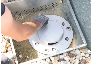
Bild 15: Retentionsablauf für Flachdächer (Quelle: LOROWERK)
