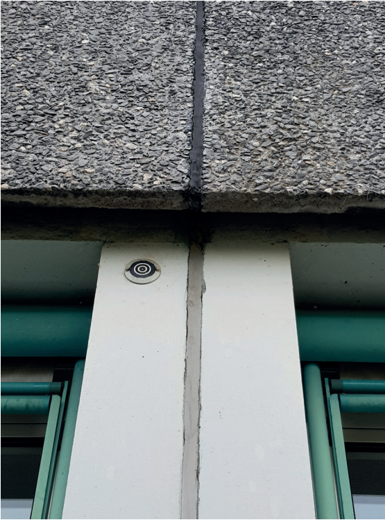
Abb. 2.2-1: Mit Dichtstoff abgedichtete Fuge, Quelle: Schmidt
