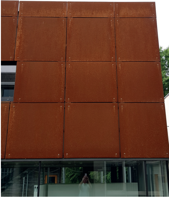
Abb. 2.2-2: Fugen als Gestaltungselement, Quelle: Schmidt
