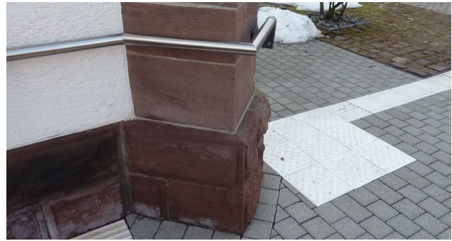
Bilder 19: Ausführung Handlauf entlang Sandsteinpfeiler mit Aufmerksamkeitsfeld (Quelle: faktorgruen, Landschaftsarchitekten, Rottweil)
