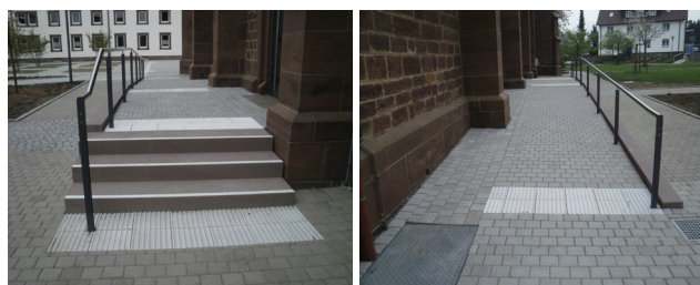
Bilder 13, 14, 15: Rampenanlage mit Treppe am Seiteneingang Klosterkirche (Quelle: faktorgruen, Landschaftsarchitekten, Rottweil)
