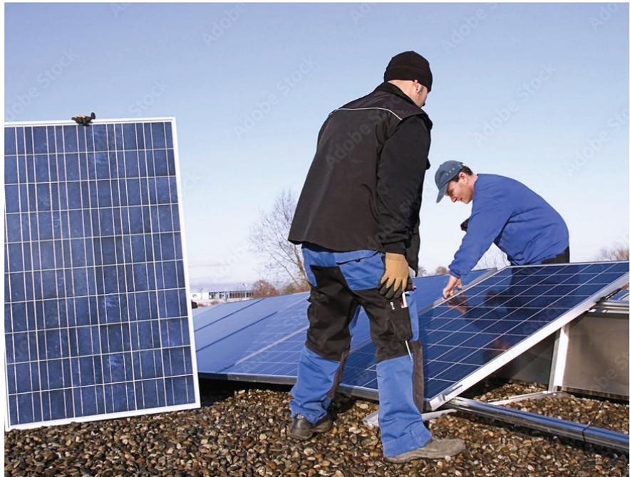
3 | Ist nach Errichtung eines Neubaudaches, nachträglich die Installation einer PV-Anlage geplant, sollte auf die Nichtbrennbarkeit der verwendeten Baustoffe geachtet werden. Gerade das Material der Dachabdichtung ist nach Fertigstellung des Daches oftmals endgültig.
