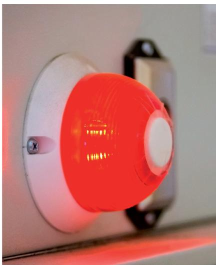
Eine Kombination aus optischem und akustischem Signal ermöglicht eine sichere und barrierefreie Wahrnehmung im Brandfall.
