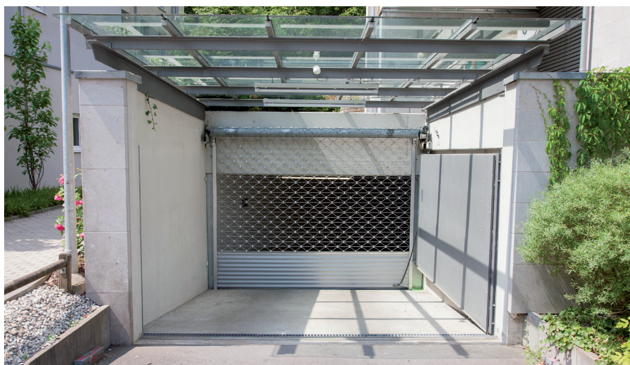
Tiefgaragen sollten ein- bis zweimal pro Jahr u. a. auf Schäden durch Feuchteinflüsse überprüft werden.
