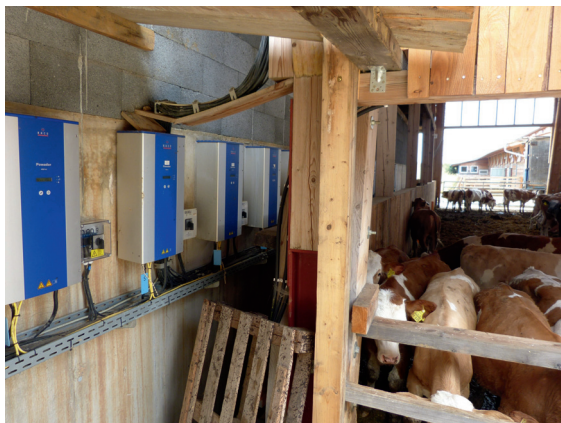
Abb. 3.7-2: Ungünstige Zugänglichkeit sowie Gefahr durch Tiere, Quelle: SV Schröder
