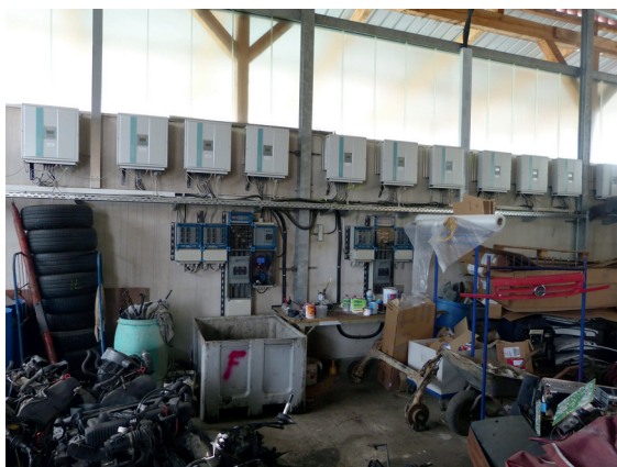
Abb. 3.7-3: Kritisches Umfeld für einen Wechselrichteranbringungsort, Quelle: SV Schröder
