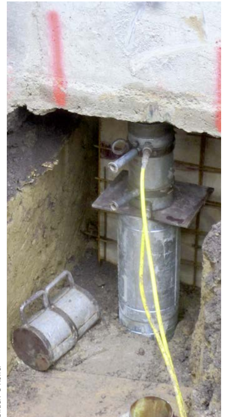
(5) Hydraulische Presse mit Zylinderkern zum Eintreiben in den Untergrund
