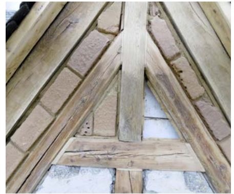
(10) Gereinigtes, in Teilen bereits instand gesetztes Fachwerk mit teilweise neuer Ausfachung mit Lehmsteinen
