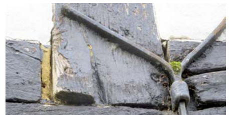
(11) Vor der Sanierung: Verbliebener historischer Zuganker mit sichtbarem, aufliegendem biologischen Bewuchs. Die Y-förmige Ausbildung des Ankers leitete oberflächlich abfließendes Wasser in die Holzkonstruktion.
