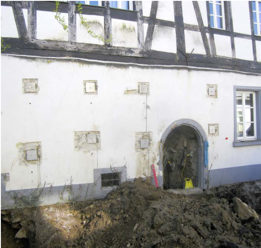
(4) Grundsicherung der Giebelwand
