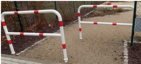
Bild 250: Eine schleusenförmige Ausführung verlangsamt die Geschwindigkeit. (Quelle: GAO – Gesundheits- und Arbeitsschutz Onischka UG [haftungsbeschränkt])
