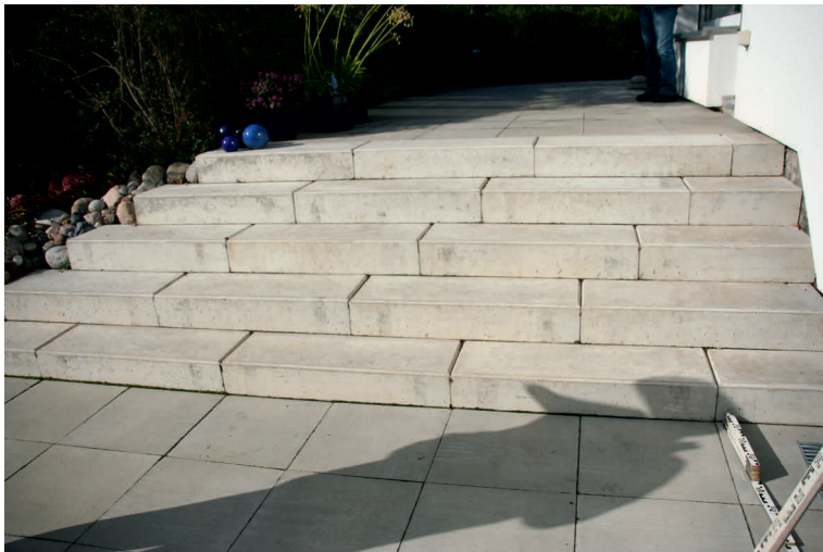
Bild 1: Treppenstufenanlage aus Sichtbetonfertigteilen (Quelle: Jutta Curtius)
