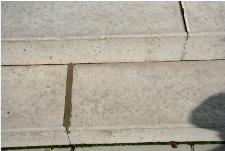
Bild 2: Ausspachtelung der Rillen (Quelle: Jutta Curtius)
